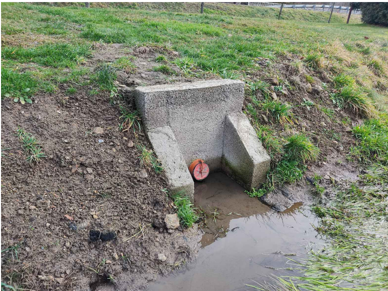
Pohled na výtokový objekt z domovní ČOV
